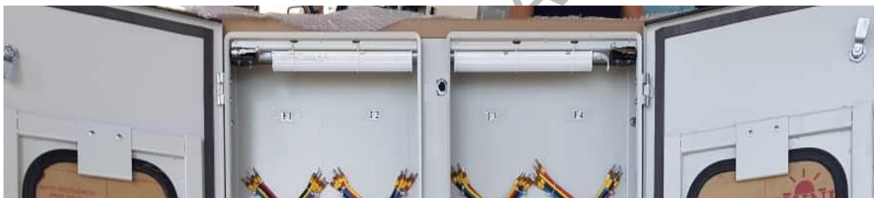
شکل شماره (پ ۷-۴) محل خروج سیم مودم در ستون بین دو بخش کنتور
