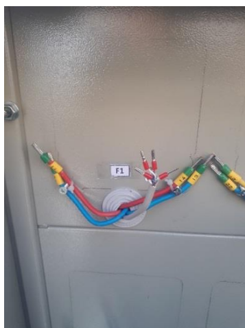
شکل (پ۷-۱) محل شروع سیم قرائت از راه دور از کنتور شماره F1
