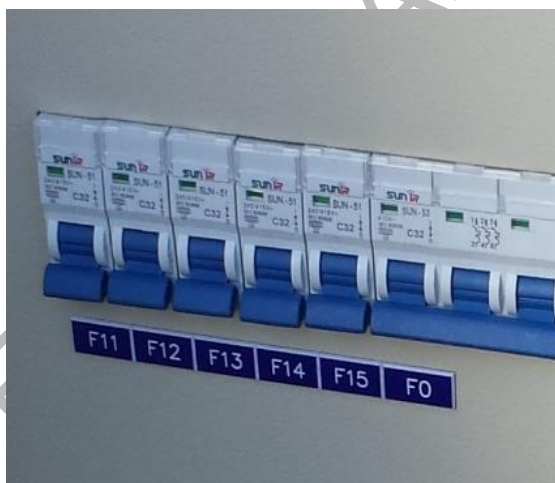
شکل (پ ۱): روش برچسب گذاری کلید مینیاتوری افقی
