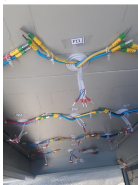
شکل (پ۷-۲) سیم کشی قرائت از راه دور
